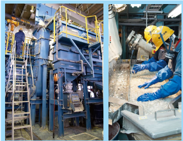
JIG設備 比重選別によりさらに細かい分別を行います。
