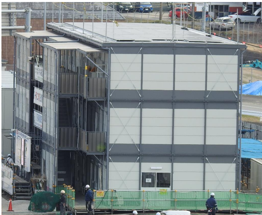
写真：屋上設置 写真
